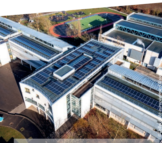
Photovoltaikanlagen auf einem Collège in Truchtersheim. Panneaux photovoltaïques sur le collège de Truchtersheim.
